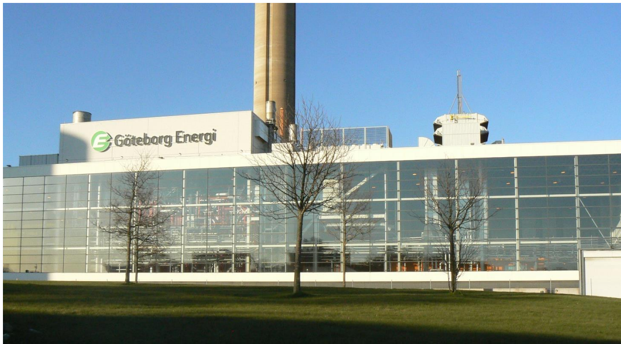
Figur 3. Naturmarksinslagen i planområdet är begränsade. Närmast väster om Rya kraftvärmeverk finns ytor med gräsmattor och planterade lövträd.
